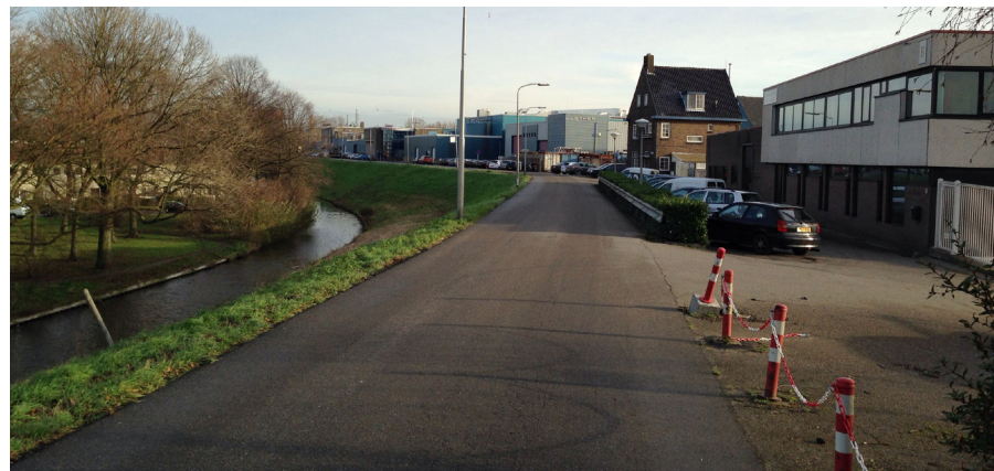
Wegdek op kruin loopt over in verharding industrieterrein
