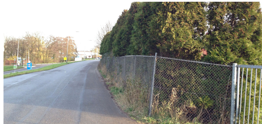
Geen zicht op rivier door dichte begroeiing langs de dijk
