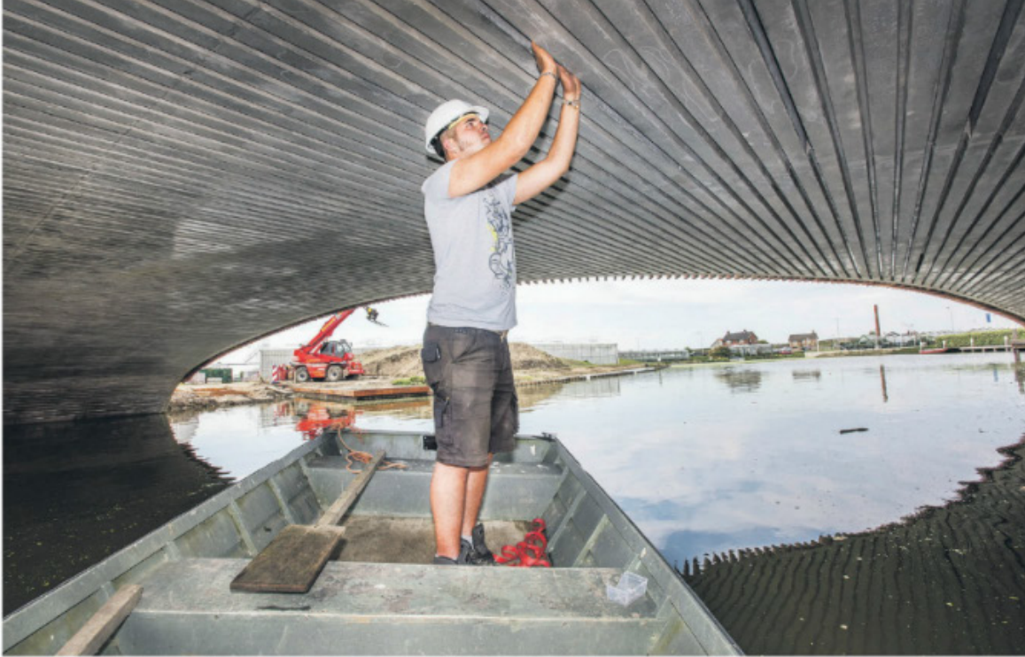
Een van de bouwvakkers legt de laatste hand aan de vleermuisbrug in Monster, Zuid-Holland. In de richels onder de brug kunnen vleermuizen 's zomers goed verstopt slapen.
