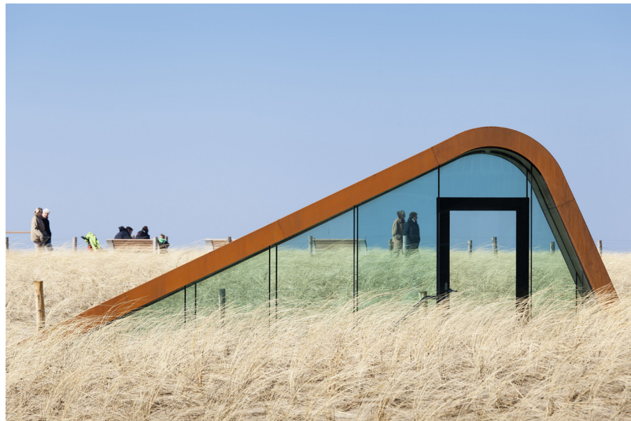
Kustwerk Katwijk: goed voorbeeld van een verbinding tussen ruimte en wateropgaven
